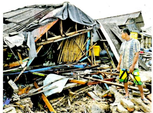
Penduduk melihat bangunan yang runtuh.
